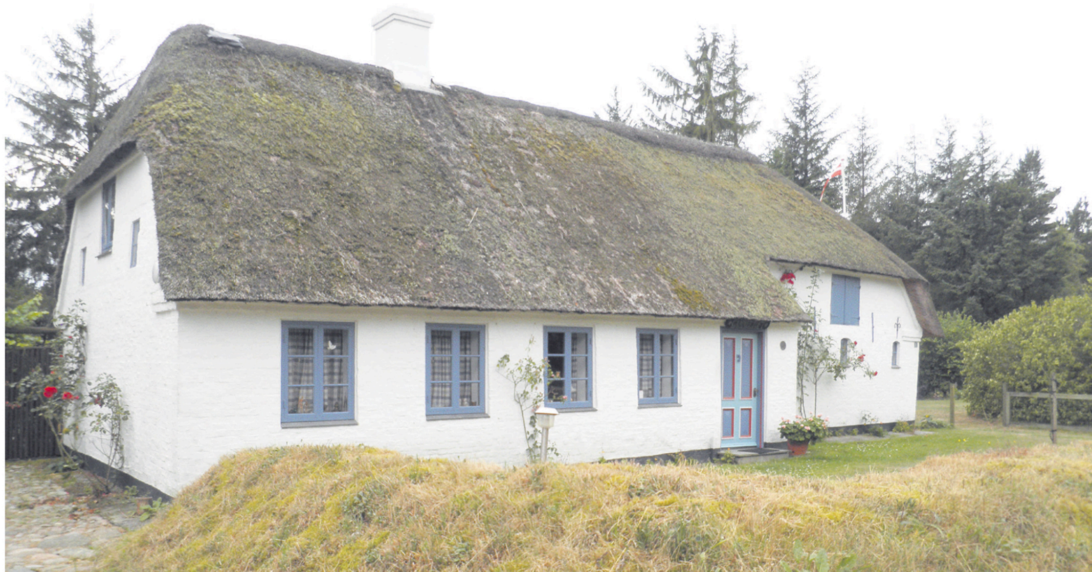
Kalket hus på Tane Hedevej i Ho. Kalk er med sin matte overflade især velegnet til gamle huse.
